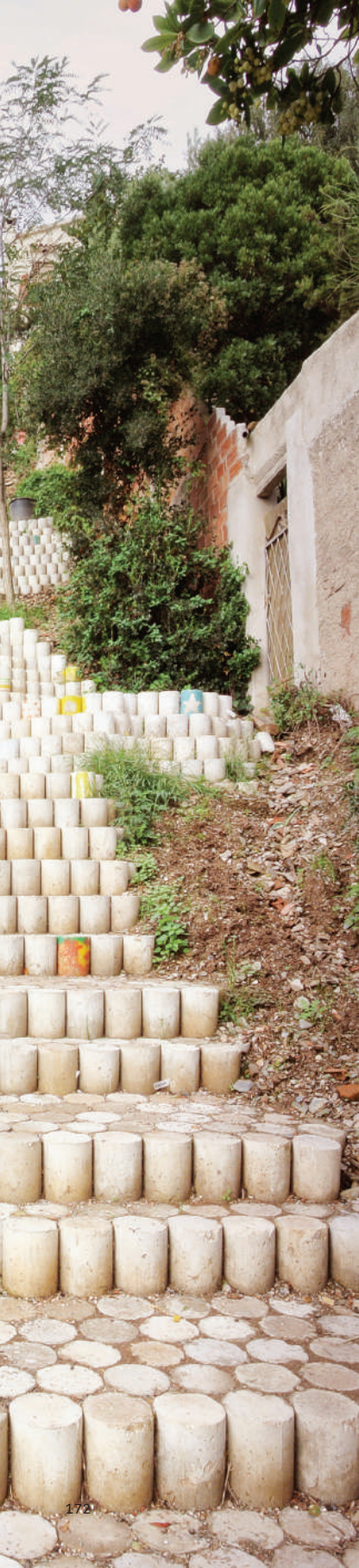
Ringo Rango. Anna Burgaya + Ruta Ringo Rango. PFC. #reutilizada. Recuperación del antiguo camino Ringo Rango mediante la construcción de una escalera con material de rechazo: probetas de hormigón.
